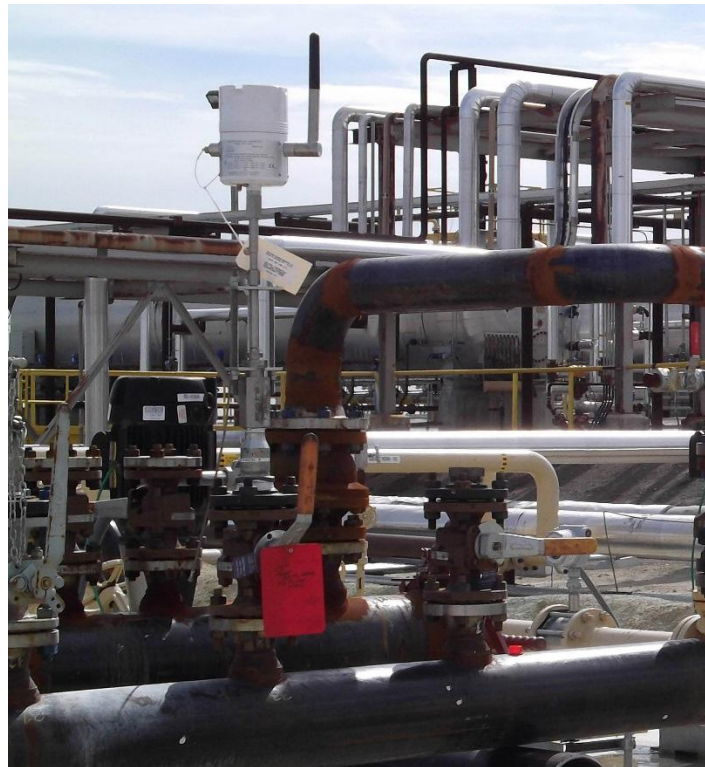
Transmissor sem fios Microcor® ER montado sobre flange e sonda retrátil
