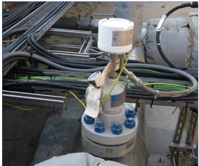
Transmissor Microcor ER Transmissor e Probe montados em conexão de acesso de alta pressão COSASCO sobre flange
