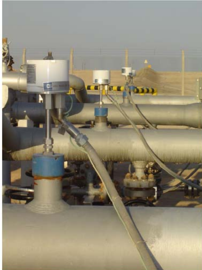
Figura 8 – Acoplamento Direto do Transmissor e Sensor
